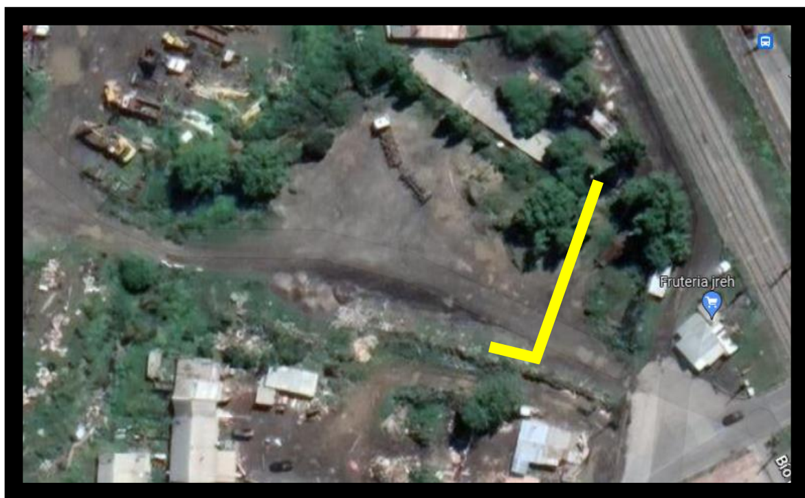
Figura 42 Ubicación Muro Perimetral Fuente: Google maps.
