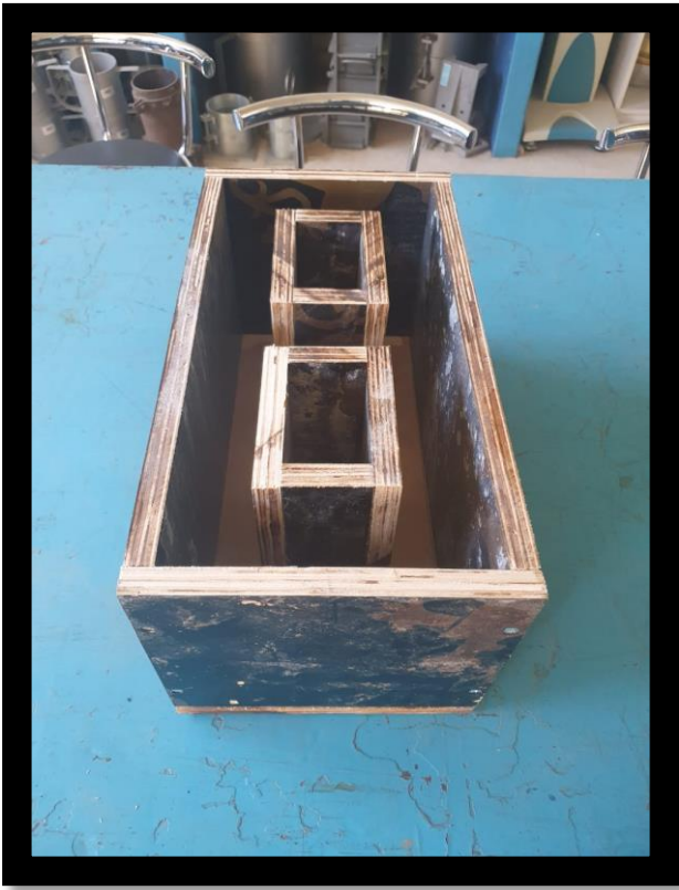
Figura 28 Aplicación Desmoldante a moldaje bloque hormigón Fuente: Elaboración propia, (2022).
