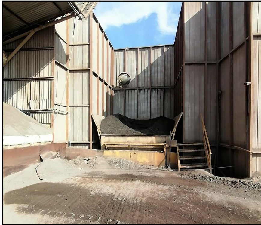
Figura 2.8. Contenedores para alimentación de RAP (Planta Bitumix Maipú). Fuente: Elaboración propia.
