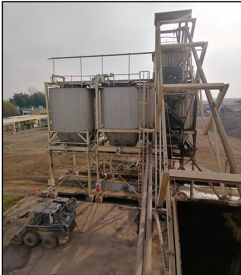
Figura 2.19. Silos estacionarios montados sobre báscula de camiones (Planta Bitumix Maipú). Fuente: Elaboración propia.
