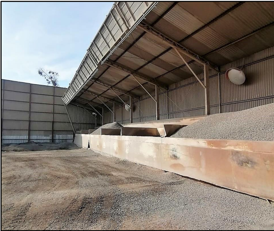
Figura 2.6. Contenedores de alimentación de áridos en frío (Planta Bitumix Maipú). Fuente: Elaboración propia.
