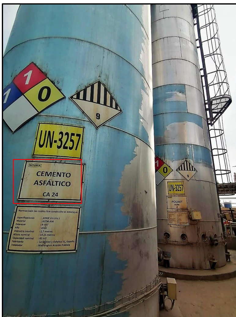
Figura 2.5. Tanques de almacenamiento de ligante asfáltico (Planta Bitumix Maipú). Fuente: Elaboración propia.
