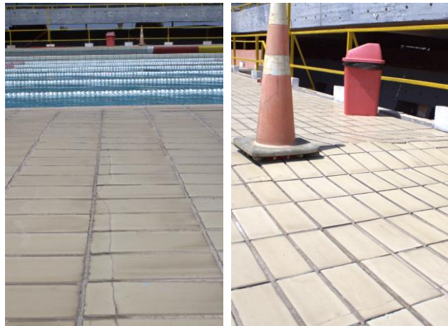
fig. 36 Registro propio del revestimiento cerámico que cubre la losa de las piscinas. Enero 2024.
