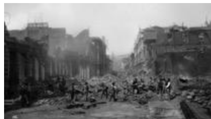
fig. 13 Valparaíso 1906, consecuencias del terremoto en calle Blanco, esquina Edwards. Fuente: https://laderasur.com/fotografia/115-anos-del-terremoto-de-1906-en-valparaiso-recordando-la-historia-traves-de-fotografias
