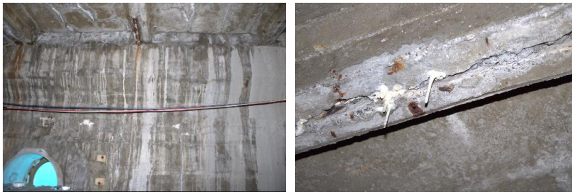
fig. 40 Registro propio en túneles al interior de piscinas. Enero 2024.
