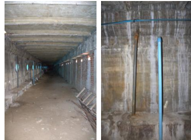
fig. 42 Registro propio de túneles al interior de las piscinas. Enero 2024.
