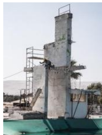
fig. 1 Demolición plataforma de saltos ornamentales, 2020. Fuente: Arica al día.
