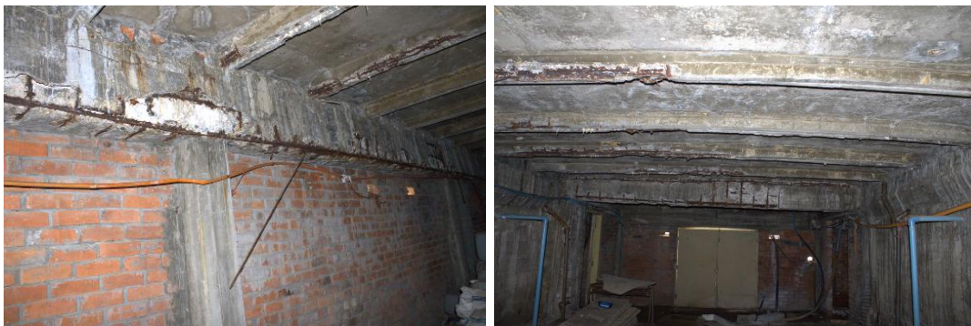
fig. 37 Registro propio al interior de los túneles inferiores de las piscinas. Enero 2024.
