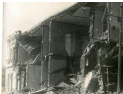
fig. 14 Consecuencias del terremoto de Talca, 1928 Fuente: https://www.latercera.com/que-pasa/noticia/revelan-desconocidas-fotos-de-gran-terremoto-ocurrido-en-chile-hace-un-siglo/FVBVEM5RINGHZDT3ITQHLBSO7I/
