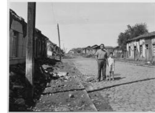
fig. 15 Consecuencias del terremoto de Chillán en 1939. Fuente: https://www.mhn.gob.cl/galeria/registro-fotografico-del-terremoto-de-chillan
