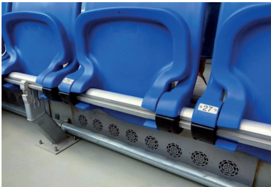
Detalle 10: climatización estadio Fuente: Google images
