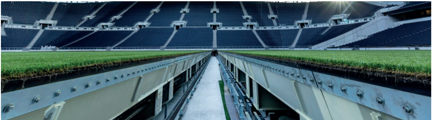
Detalle 5: Césped de Fútbol retráctil - Césped NFL Fuente: Documento Media Kit. Tottenham Hotspurs Stadium
