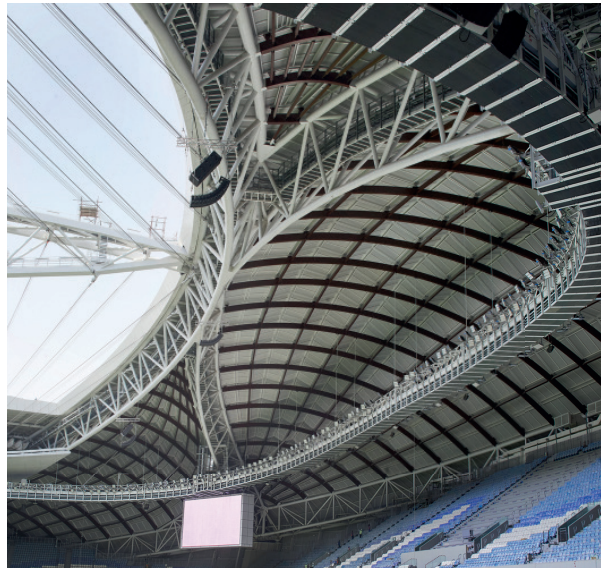
Detalle 12: Estructura interior vigas de la cubierta / "esqueleto de cascos dhow" Fuente: Google images
