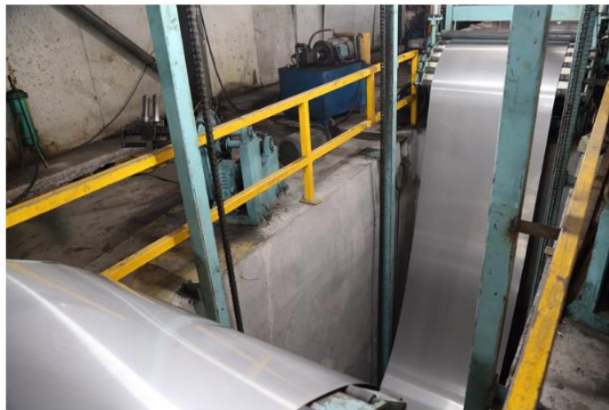
Figura 2-2. Foso de almacenamiento
