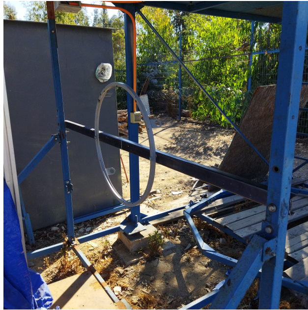
Figura C.4: Montaje de estructura soporte concentrador.
