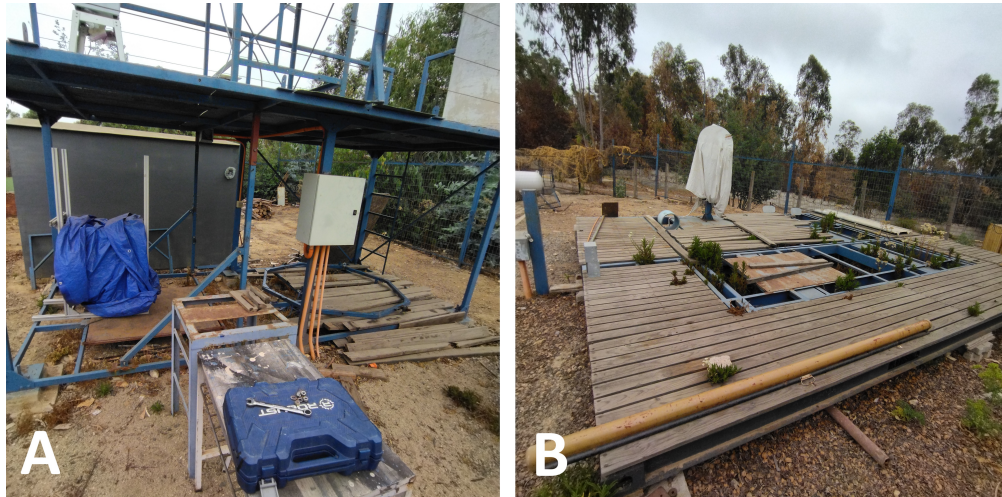
Figura 3.32: Estado del banco de pruebas solar previo a la limpieza desarrollada por el tesista (A. Zona gasificador, B. Zona heliostato)
