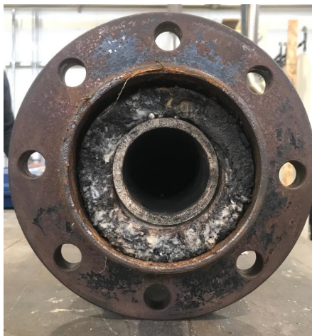
Figura 2.6: Aislación interior del reactor (fuente: propia)
