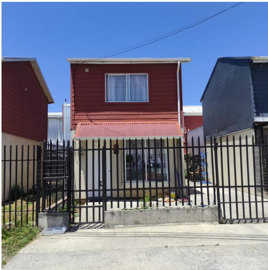
(Figura 48 fuente: Fotografía tomada al frente de la vivienda)
