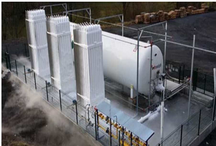
Fotografía 5: Planta satélite de regasificación de GNL
