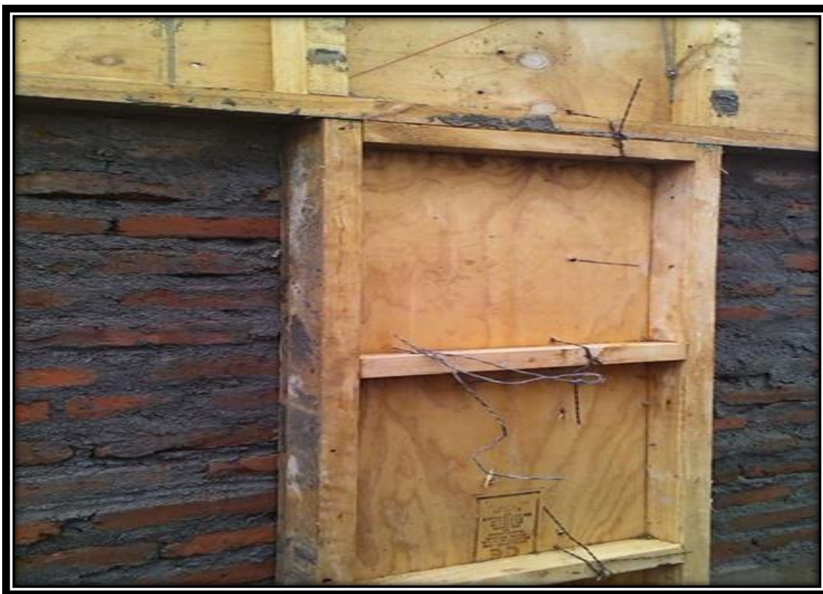
Fotografía N°6: Moldaje
