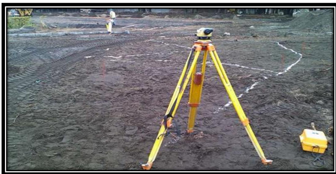
Fotografía N° 1: Trazado y niveles
