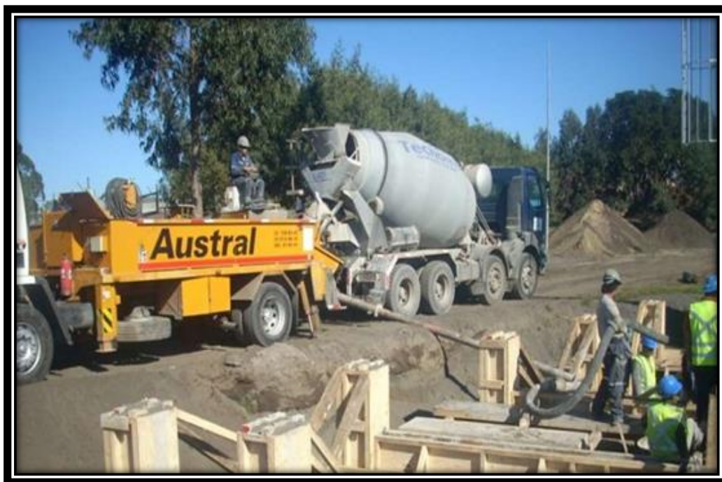
Fotografía N°9: Colocación de Hormigón
