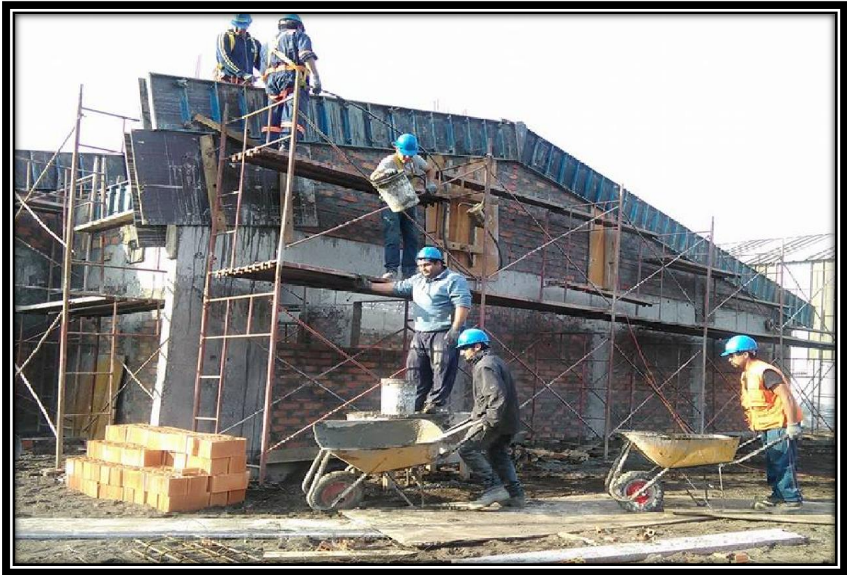
Fotografía N°10: Colocación de Hormigón
