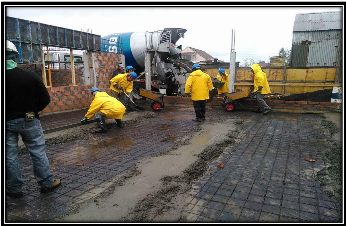
Fotografía N°5: Emplantillado
