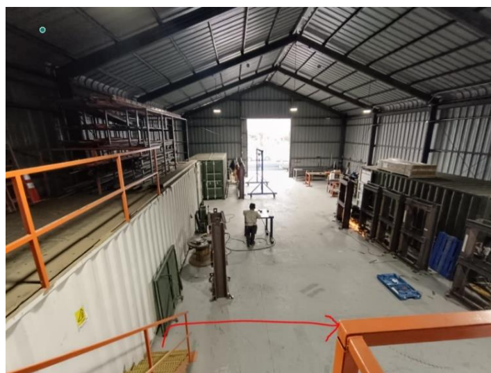
Imagen 3.7. Instalaciones sin vía de evacuación
