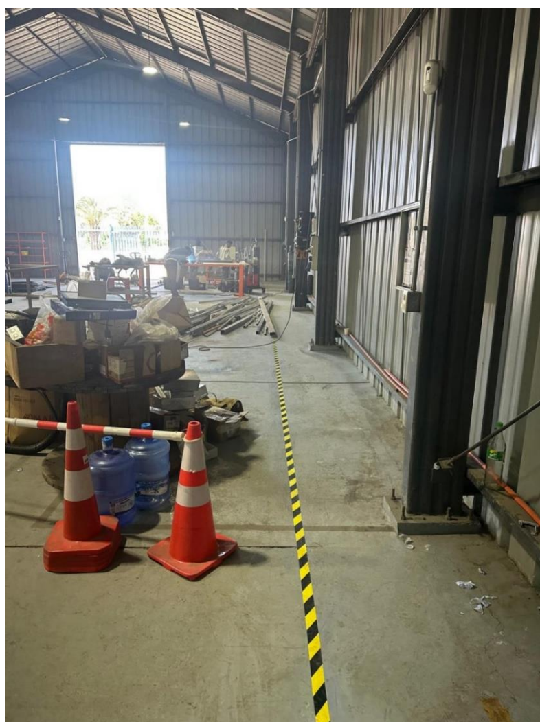
Imagen 3.8. Instalación de vía de evacuación
