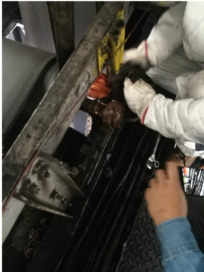
figura - 1-6: Comprobando tensión de cinta.
