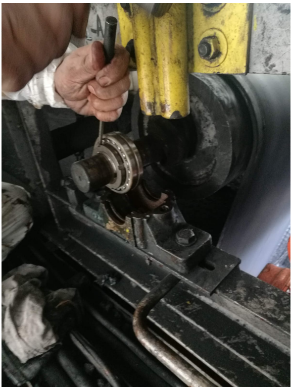
figura - 1-3: Instalación de rodamiento.
