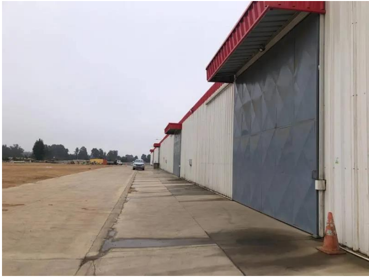
Figura 1-8. Fachada del galpón. Fuente: Portalinmobiliario.com.
