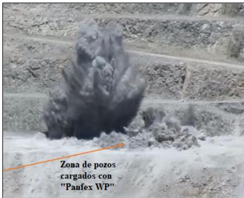
Figura 9.1: Imagen captada al momento de la tronadura.
