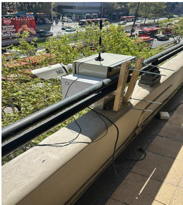
Imagen 11: Montaje USM II edificio MINVU.
