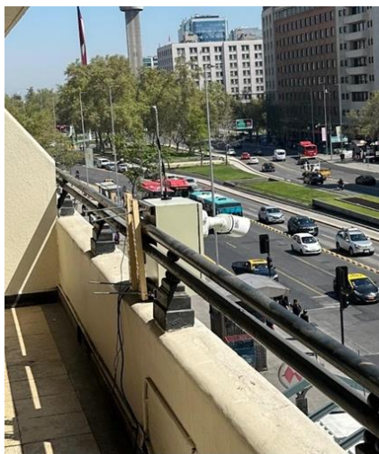
Imagen 12: Montaje USM II edificio MINVU, vista 2.
