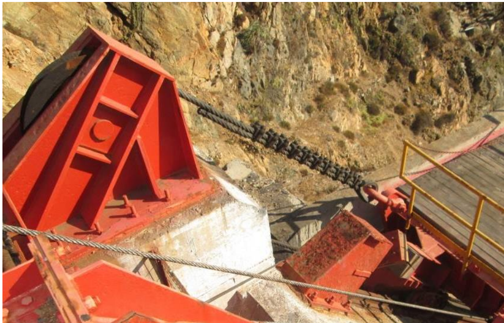
Figura 27: Polea superior de Sistema anti-deriva en carro.
