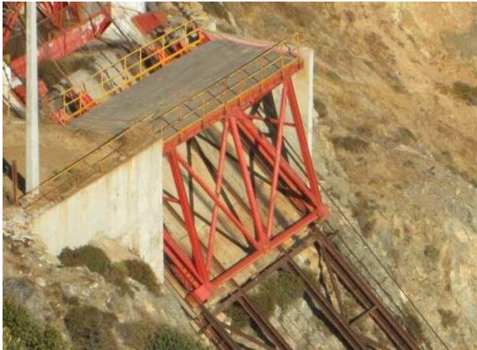
Figura 37: Plano de rodadura tomado desde la estructura superior, se observa loza y rieles fijados a Asiento de Silla.
