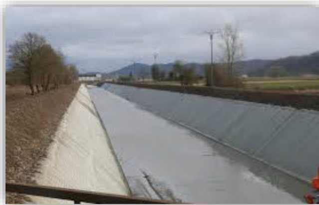
Ilustración 19: Revestimiento de hormigón.
