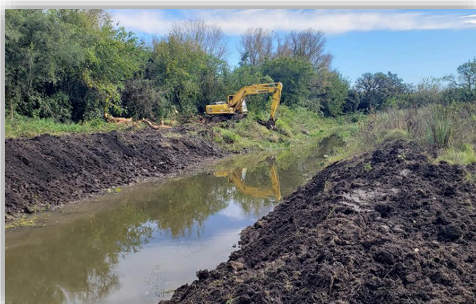
Ilustración 13: Canalización de un cauce.
