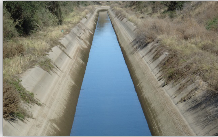
Ilustración 14: Canal de regadío revestido de hormigón.
