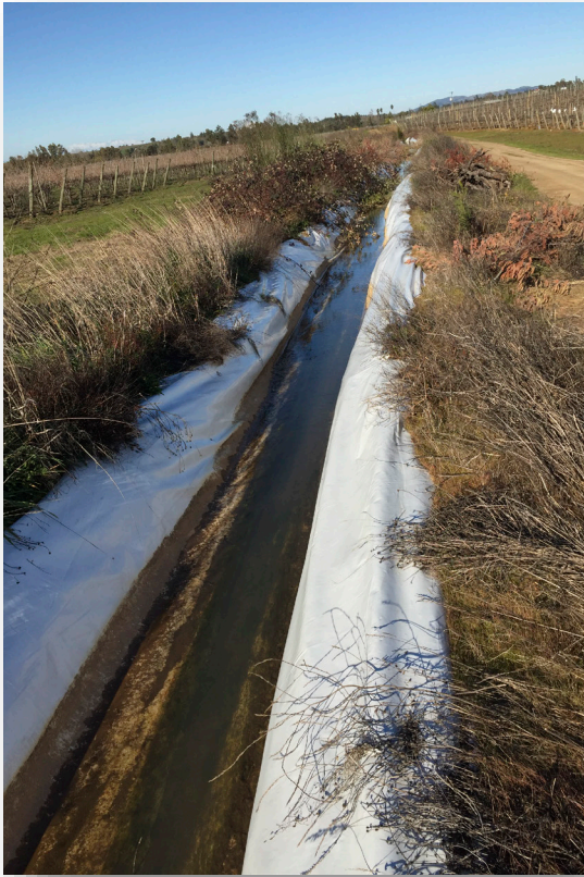
Ilustración 48: Canal Cubierto con Lona (Fuente Propia, 2019)
