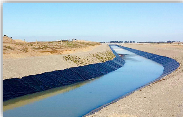
Ilustración 26: Revestimiento de Geomembrana de HDPE.
