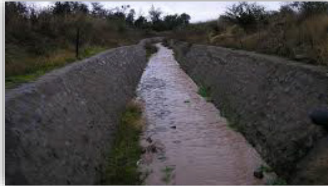
Ilustración 21: Revestimiento de mampostería.
