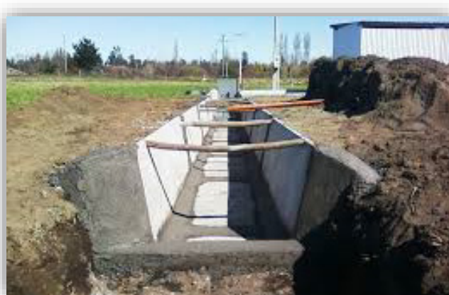
Ilustración 23: Revestimiento de losetas prefabricadas de Hormigón.
