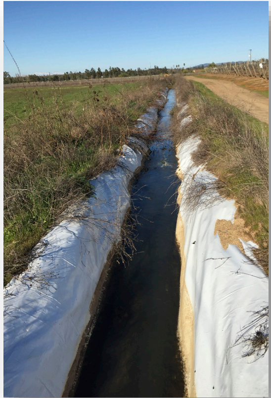
Ilustración 49: Canal Cubierto con Lona (Fuente Propia, 2019)
