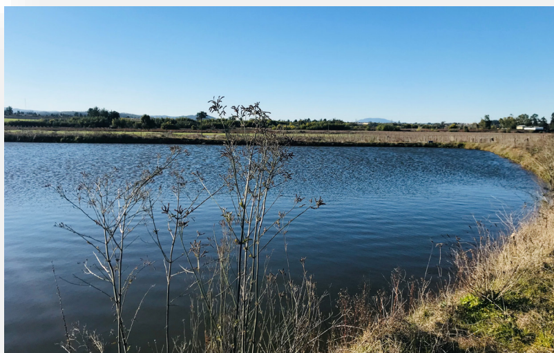
Ilustración 42: Tranque Acumulador de Aguas (Fuente Propia, 2019)
