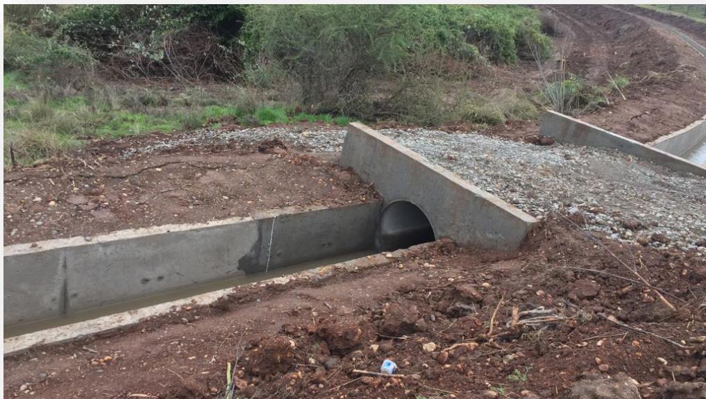
Ilustración 40: Canal Miraflores (Fuente Propia, 2019)
