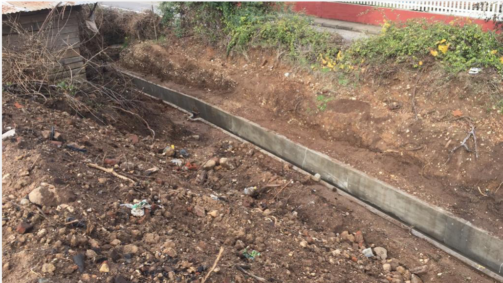
Ilustración 39: Canal Miraflores (Fuente Propia, 2019)
