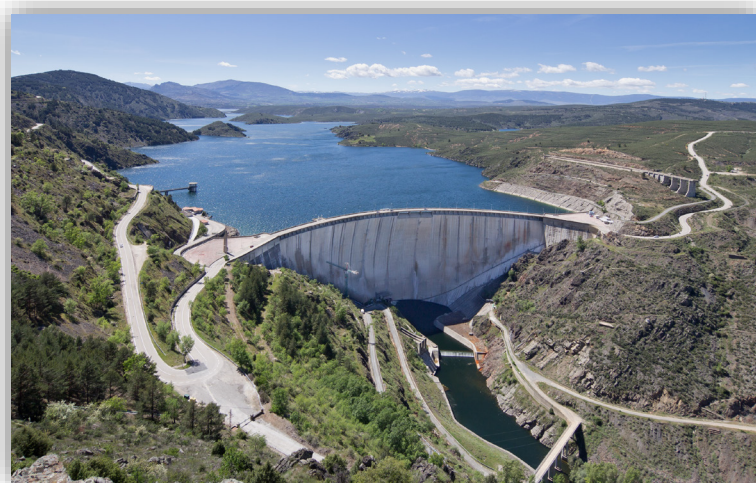
Ilustración 4: Captación de embalse El Atazar.
