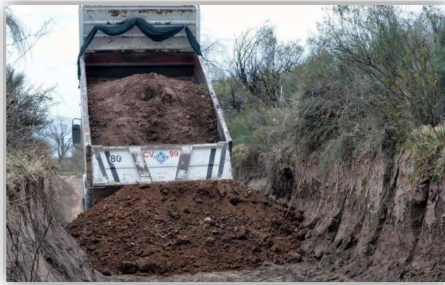
Ilustración 25: Revestimiento de suelo.
