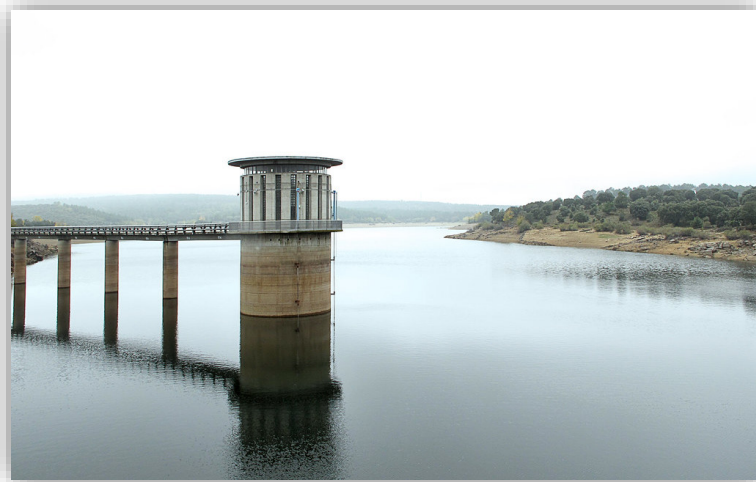
Ilustración 9: Torre de toma embalse Puentes Viejas.
