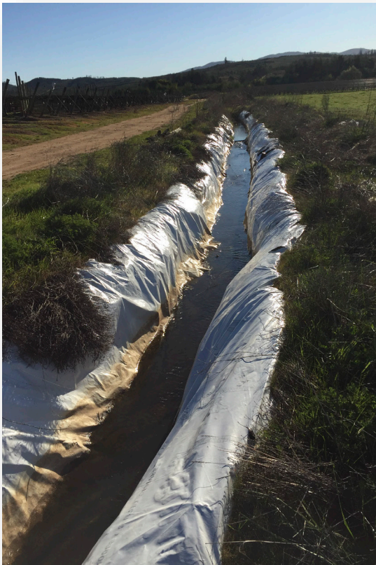
Ilustración 50: Canal Cubierto con Lona (Fuente Propia, 2019)
