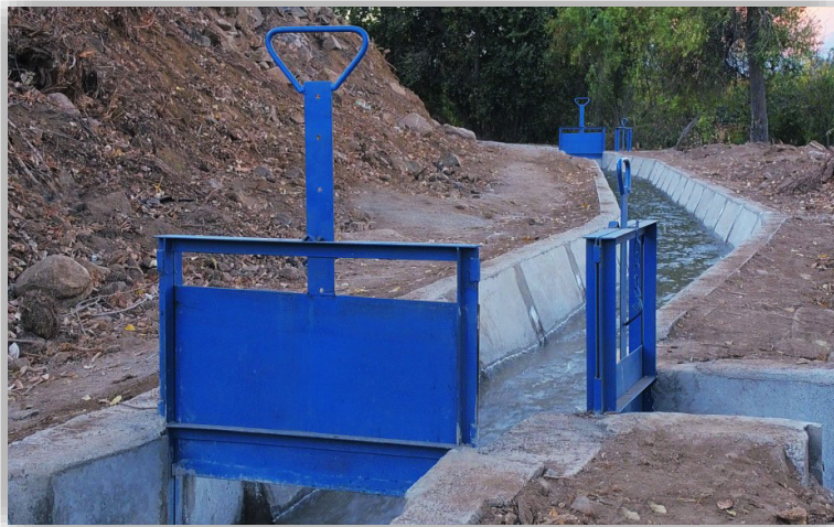
Ilustración 15: Marco partidor metálico.
