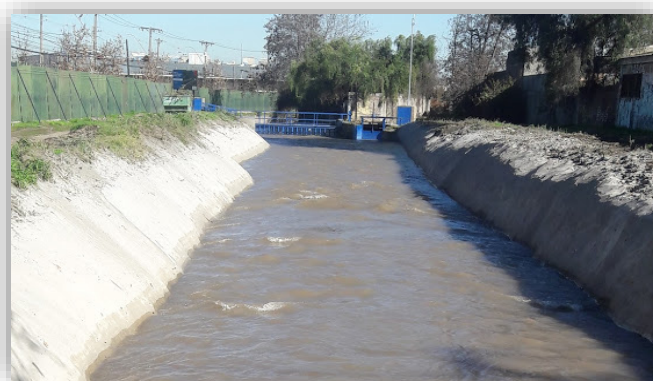
Ilustración 22: Revestimiento de Shotcrete.
