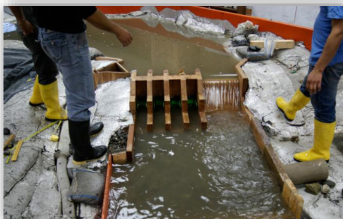
Ilustración 12: Bocatoma provisoria, pata de cabra.
