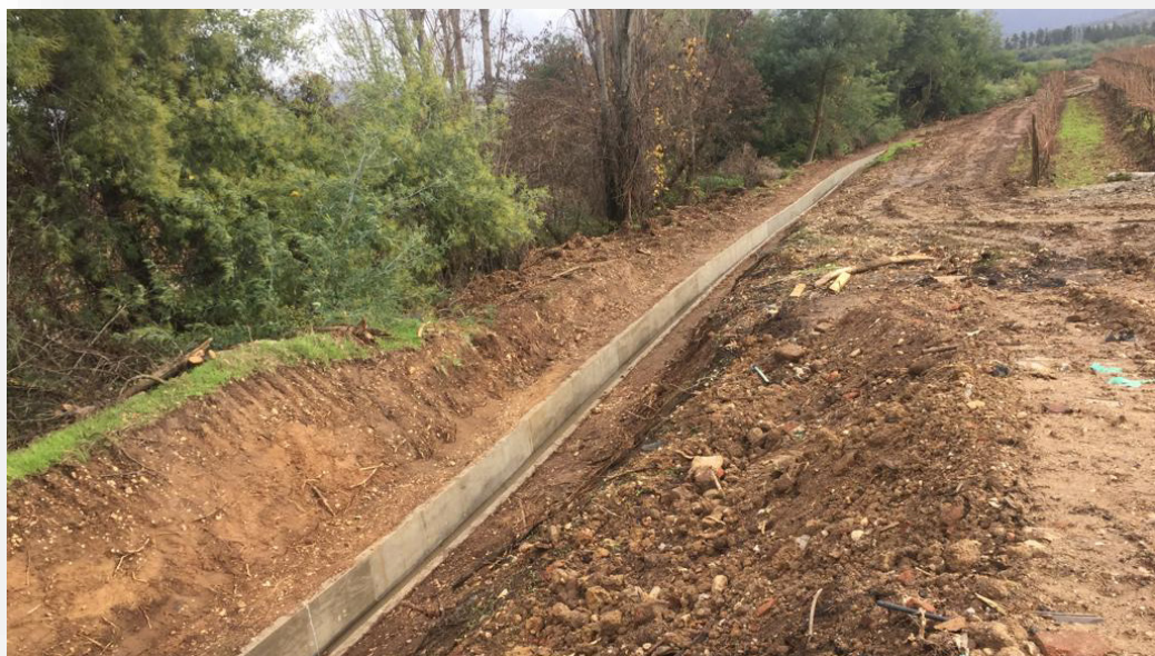
Ilustración 38: Canal Miraflores (Fuente Propia, 2019)
