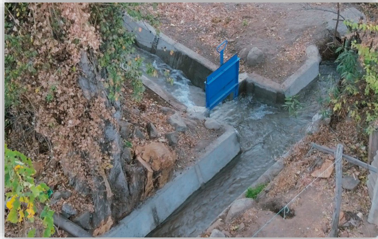
Ilustración 16: Marco partidor metálico.
