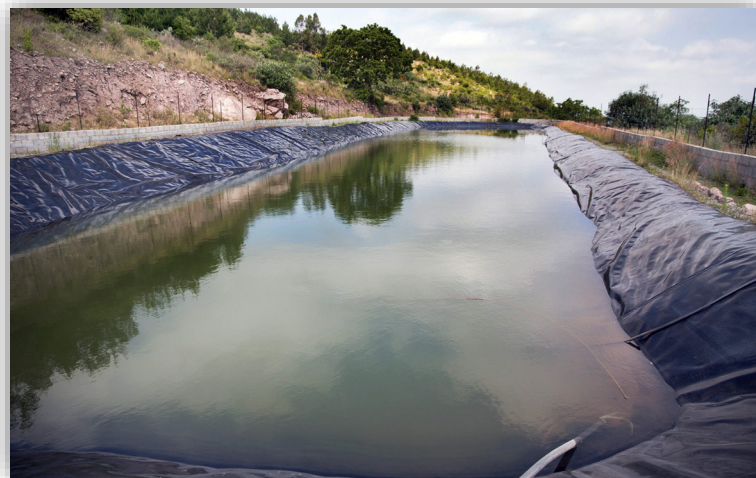
Ilustración 1: Ollas de captación pluvial.
