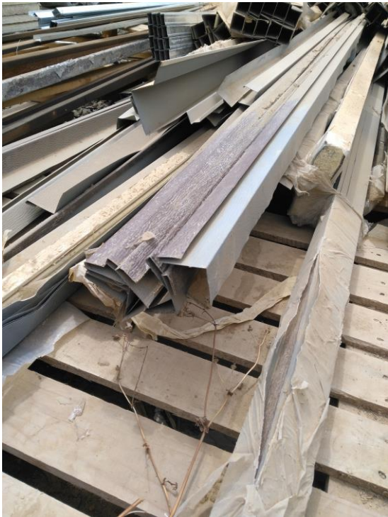
Figura2- 13 perfilaría de coronación que se utiliza en la parte inferior del isopol
