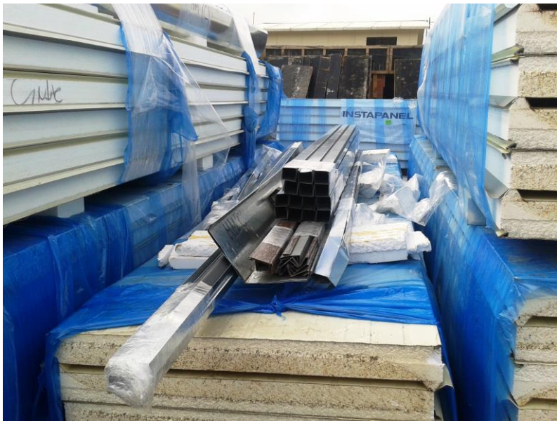
Figura2- 12 perfileria que se usa para unir tabique de isopol
