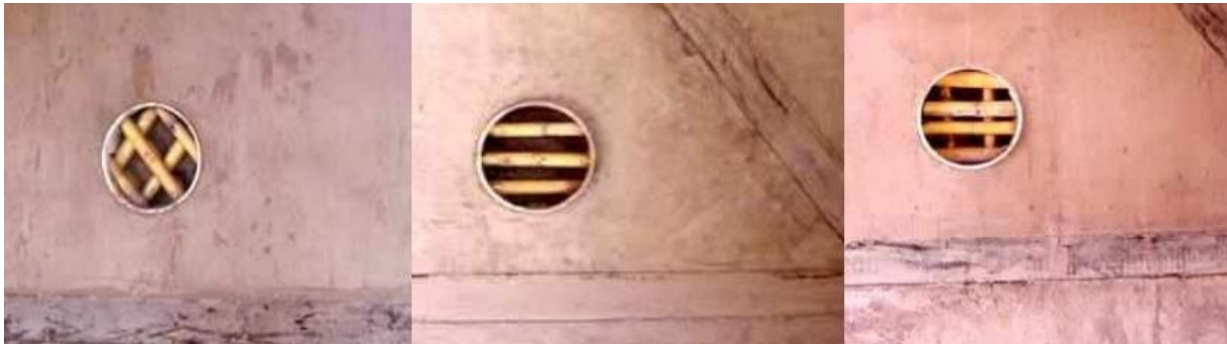
Imagen 2: Tipos de entramados para quinchá. Fuente: Fernández, Esteves, Oviedo y Buenanueva (2005).
