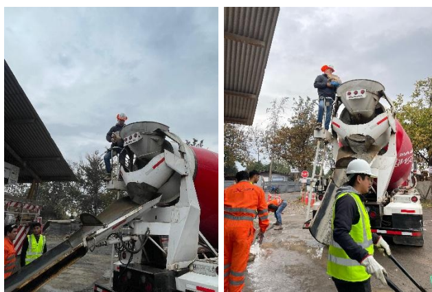
Figura N° 13 Incorporación de fibras a hormigón.
