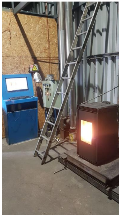
Figura 4.12: Espacio donde se ubica el sistema de control para ensayos
