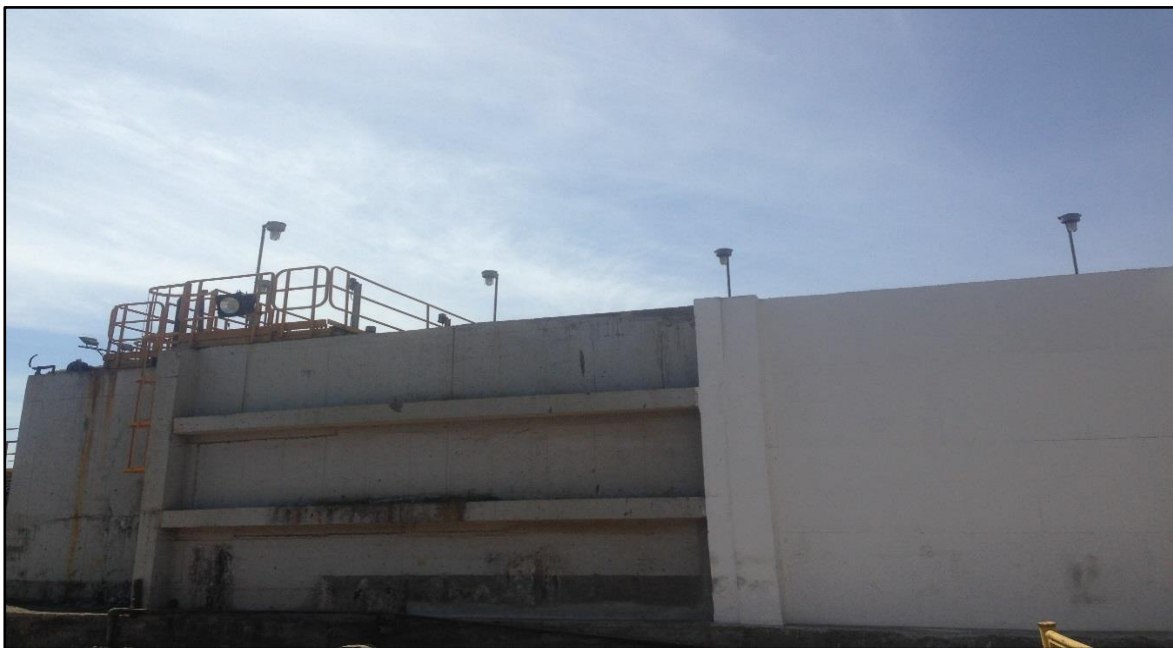
Figura 70: Piscinas de sedimentación de la planta de RILes Puerto Collahuasi.
