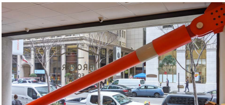
Figura 6: Disipador viscoso lineal en diagonal
