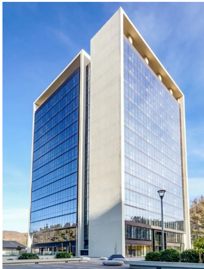
Figura 33: Edificio de las empresas Reitz III
