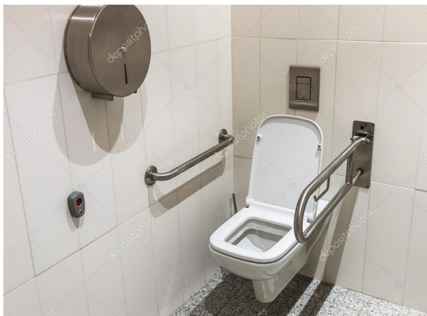
ACCESORIOS DEL BAÑO: deben ir instalados a una altura no superior a 120 cm del suelo.
