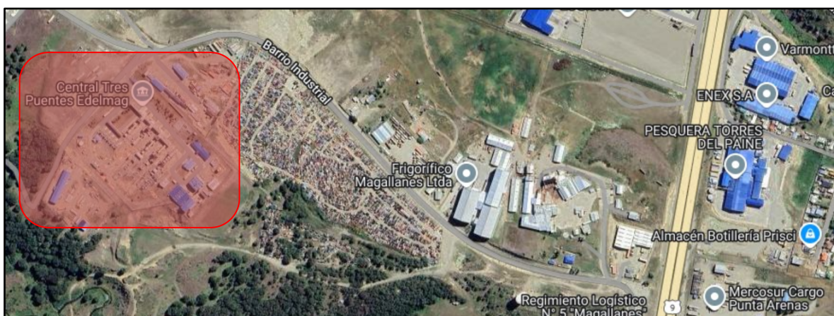
Figura N° 20: Central Tres Puentes, EDELMAG, Punta Arenas.
