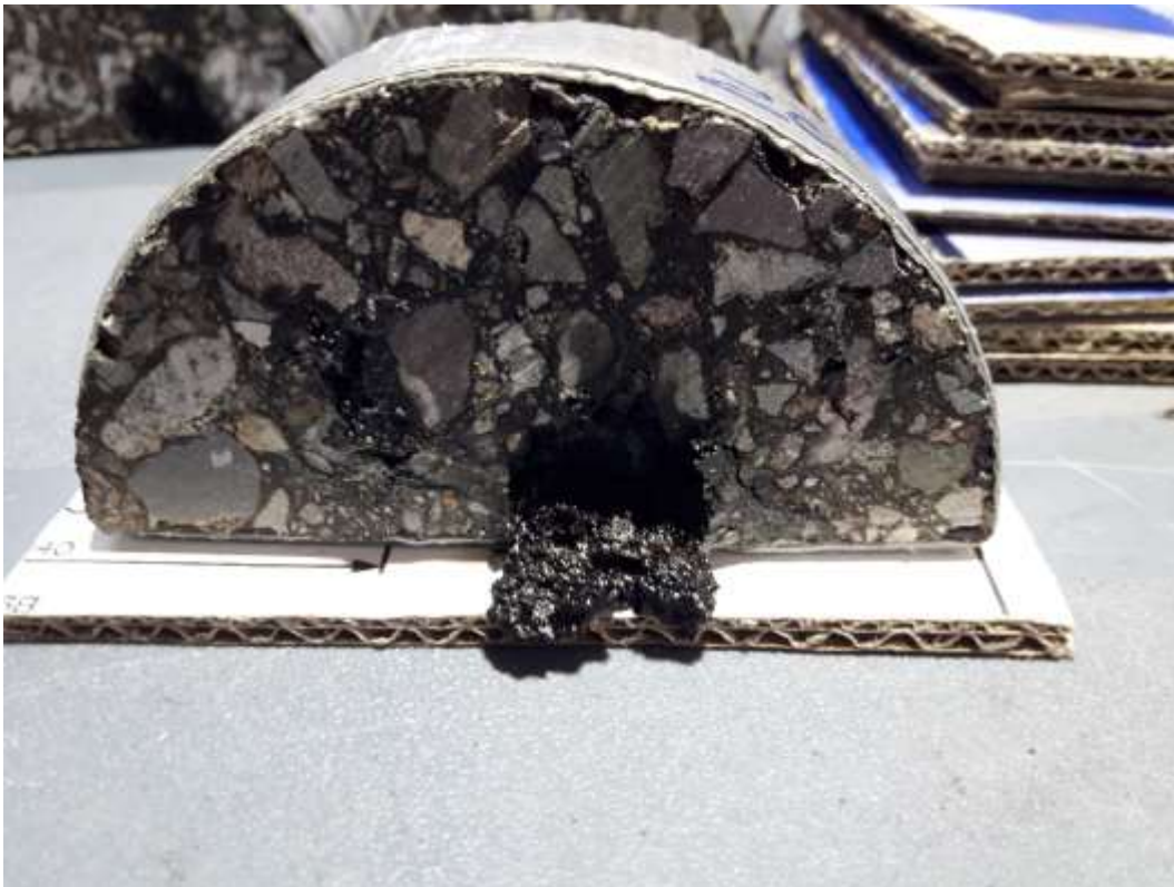
Figura 4-9 Movimiento de material por ausencia de confinamiento
