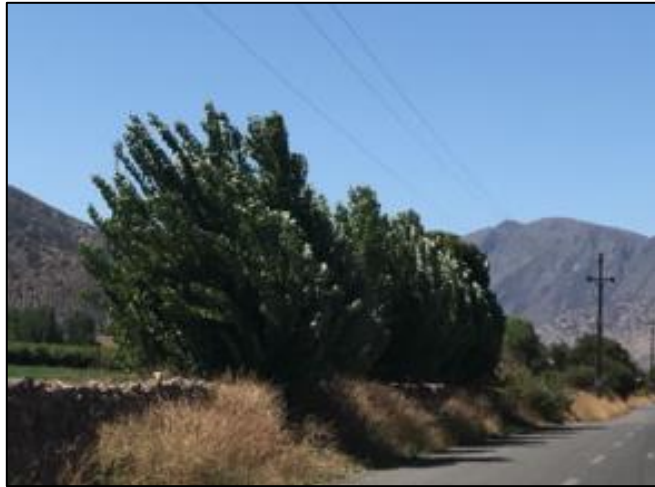
Figura D.3 Árboles bajo la línea 44kV Chagres-Los Ángeles E73-E74
