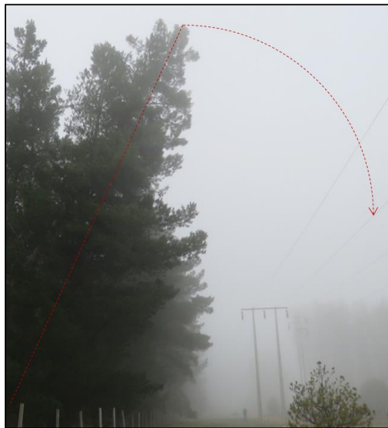
Figura D.4 Árboles con proyección de caída Línea 110kV San Antonio - Tap Algarrobo E201-E202
