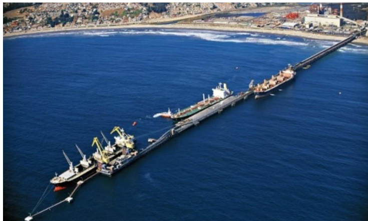
Ilustración 11: Vista general muelle Puerto Ventanas (Cámara Aduanera de Chile, 2019)
