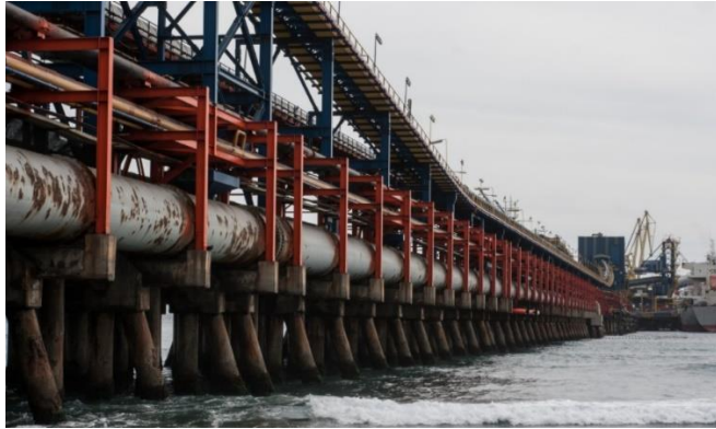
Ilustración 14: Vista lateral estructura soporte de ductos en Puerto Ventanas (Puerto Ventanas S.A., 2020)
