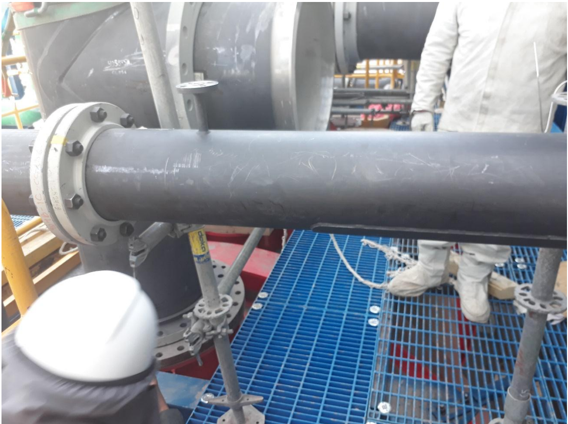
Figura 2-36 Unión de flange
