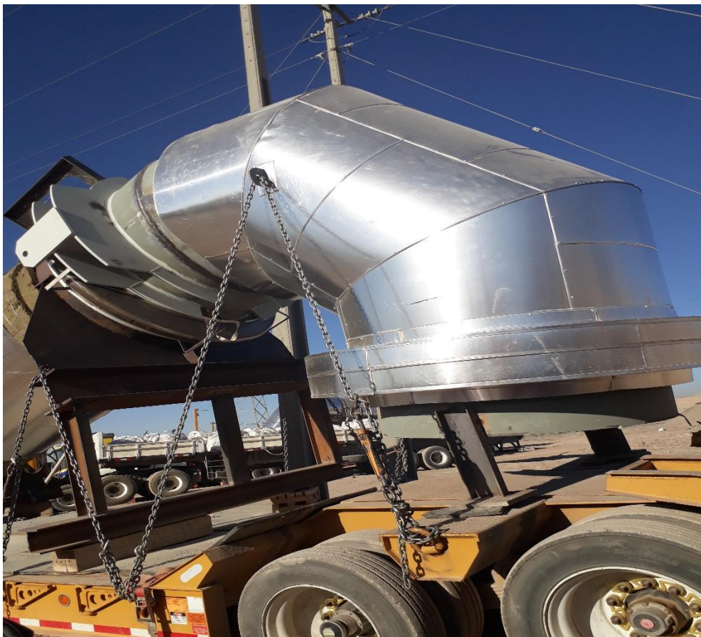
Figura 2-14 Levantamiento Línea 4011, Ducto siendo transportado a planta ácido
