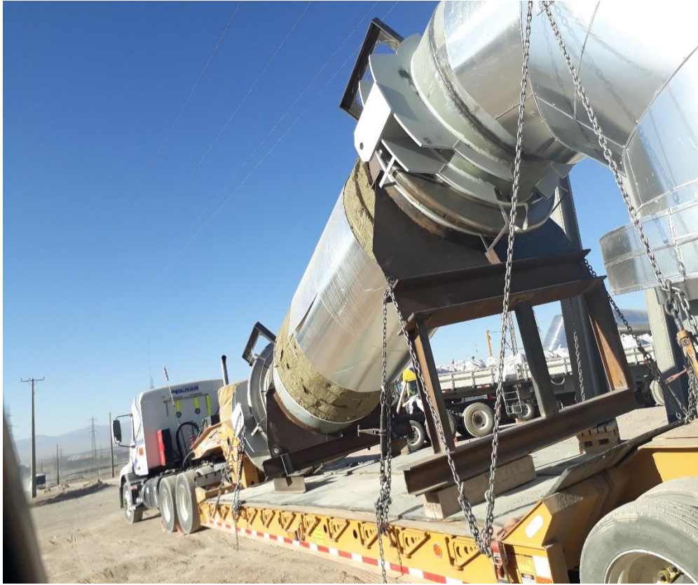
Figura 2-15 Levantamiento Línea 4011, Ducto siendo transportado a planta ácido
