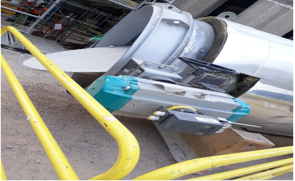
Figura 2-17 Levantamiento Línea 4020, Ducto con DUMPER finalizado
