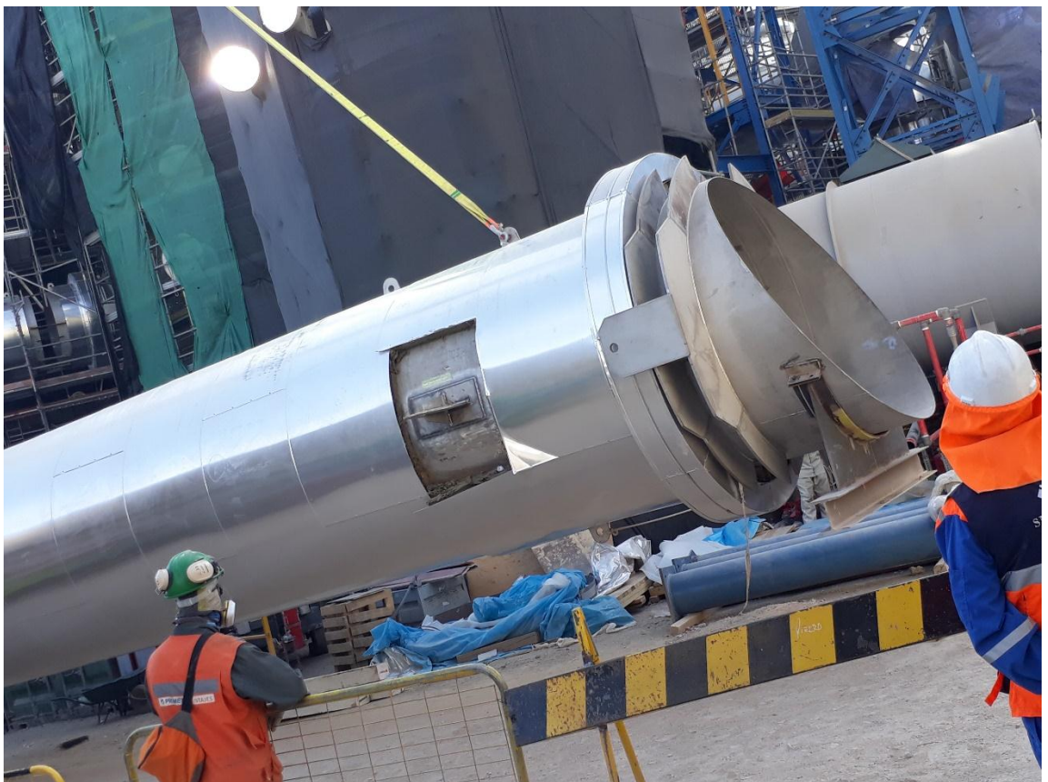
Figura 2-16 Levantamiento Línea 4012, Ducto con procedimiento de Izaje para su montaje
