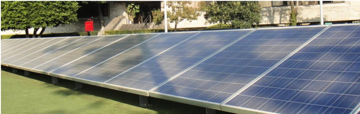
Figura 8-1: ejemplo de paneles sombreados en operación es importante considerar esta variable en su instalación.
