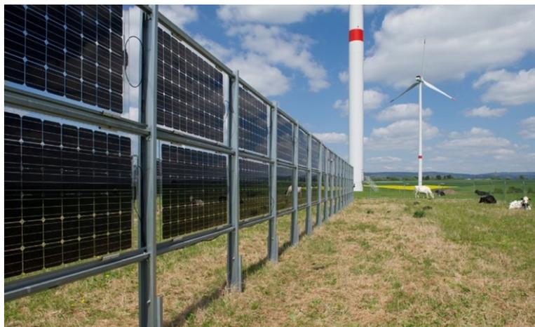
Figura 3-4: paneles bifaciales en operación [6], se destaca la posibilidad de ubicarlos sin un ángulo de inclinación.
