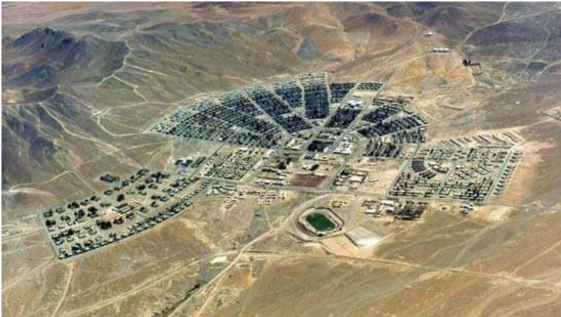
Figura 2: Vista aérea del Campamento minero El Salvador.
