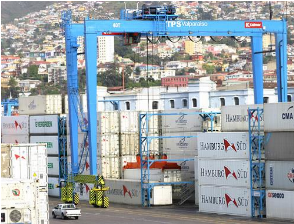
Figura 8. Vista Grúa RTG
