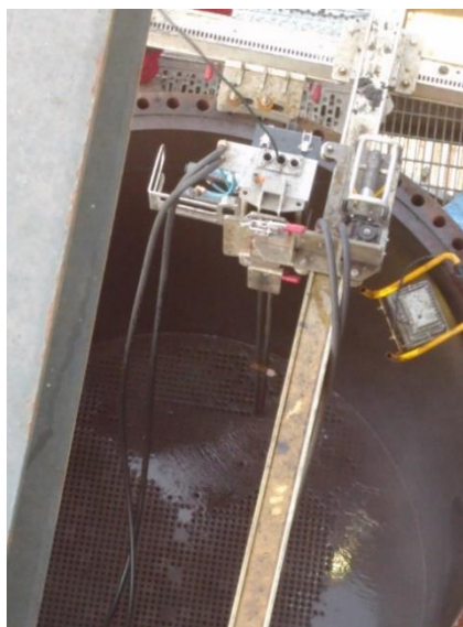
Figura 17. Mantenimiento de intercambiador de calor C-371 en Octubre del año 2016.
