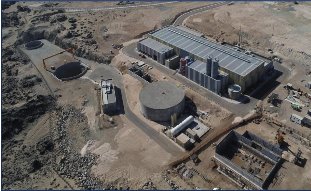
Ilustración 4: Planta Desalinizadora ECONSSA.
