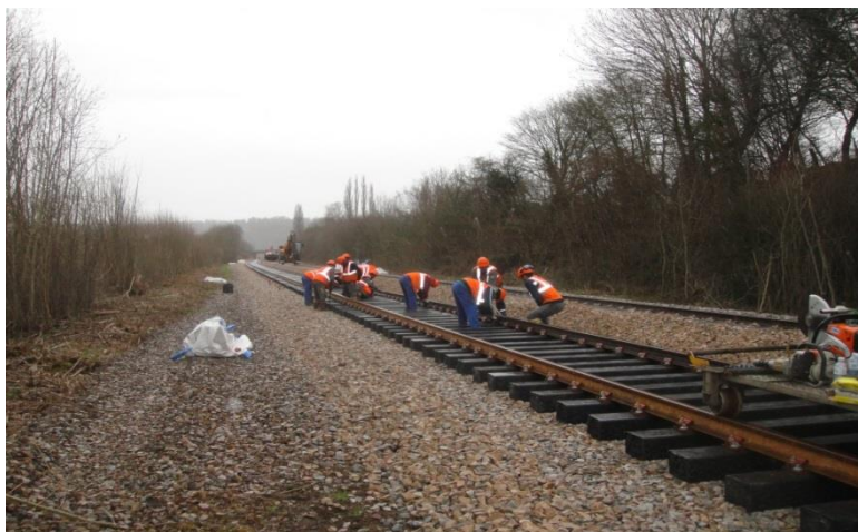
Foto 3-11: Instalaciones de rieles y fijaciones.
