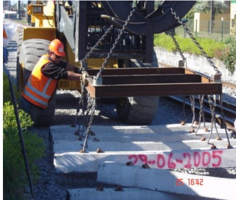
Foto 3-4: Colocación de durmientes mediante retroexcavadora con plataforma para durmientes.
