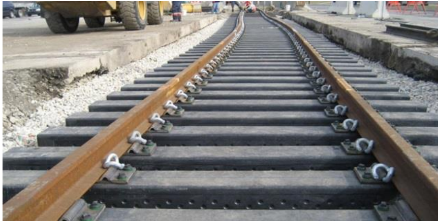
Foto: 2-4: Durmientes reciclados
