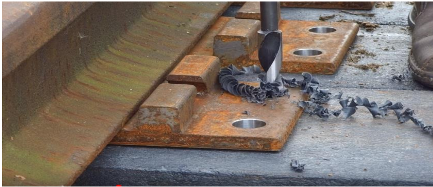
Foto 3-6: Perforación de durmiente reciclado.
