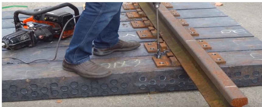
Foto 3-6: Perforación de durmiente reciclado mediante broca industrial
