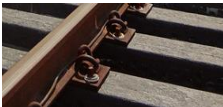
Foto 2-10: Acercamiento de fijaciones en durmientes reciclados.
