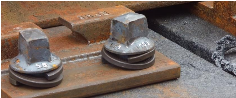
Foto 3-9: Fijación de tirafondos.
