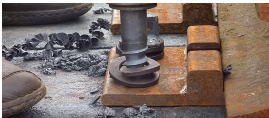
Foto 3-8: Apriete de tirafondo mediante desatornillador industrial.
