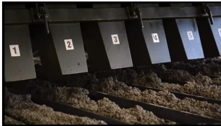
Foto 2-13: Proceso de mezclado en caliente (Producido por trituradoras).
