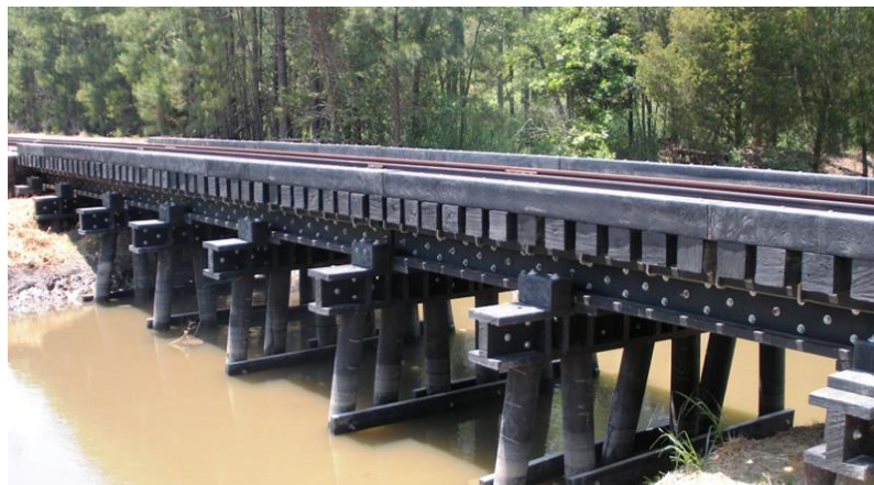
Foto 2-8: Puente sobre durmientes reciclados en el estado de Virginia (EE.UU), para trenes de carga.
