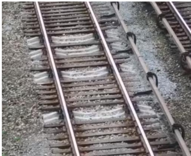
Foto 3-1: Durmientes reciclados instalados en vías de hormigón pretensado.
