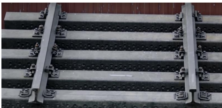
Foto 3-12: Instalaciones de fijaciones pandrol.
