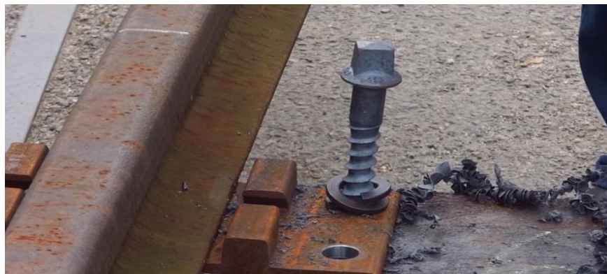
Foto 3-7: Colocación de tirafondo en silleta.
