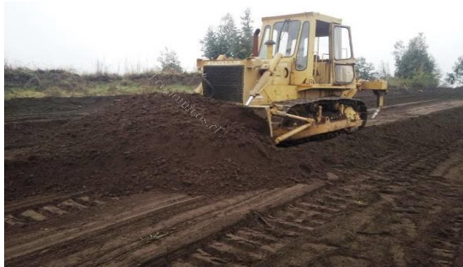
Foto 3-1: Movimientos de tierra por maquinaria bulldozers.
