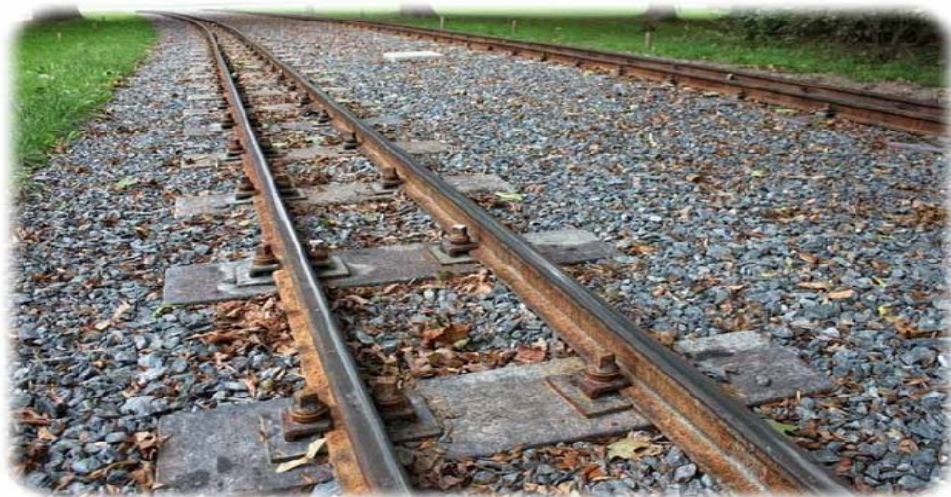
Foto 2-5: Primeros durmientes reciclados instalados en tranviaProhlis Alemania (Fotografía tomada 12 años después año 2015, no presentan ningún deterioro)
