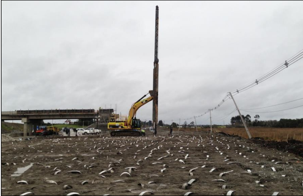
Figura 2-20: Instalación de drenes. Fuente: Referencia (14).
