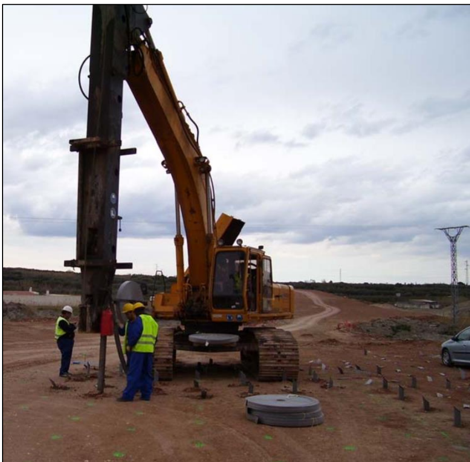
Figura 2-1: Hincass de drenes verticales prefabricados. Fuente: Referencia (3).
