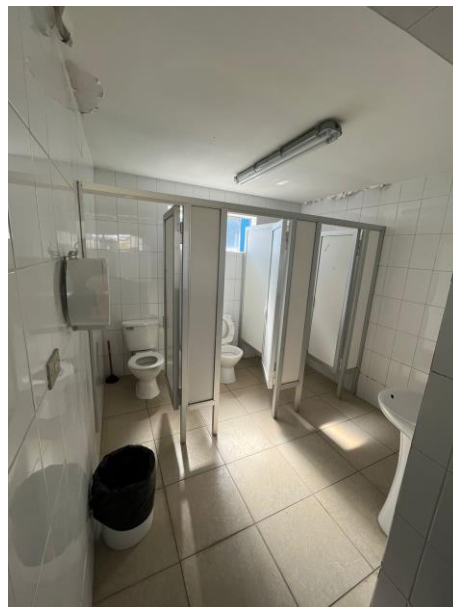
Figura 22: Estado actual del baño
