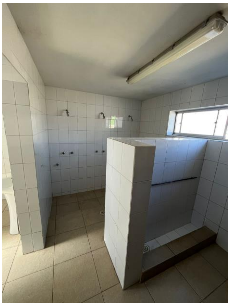
Figura 23: Estado actual antesala
