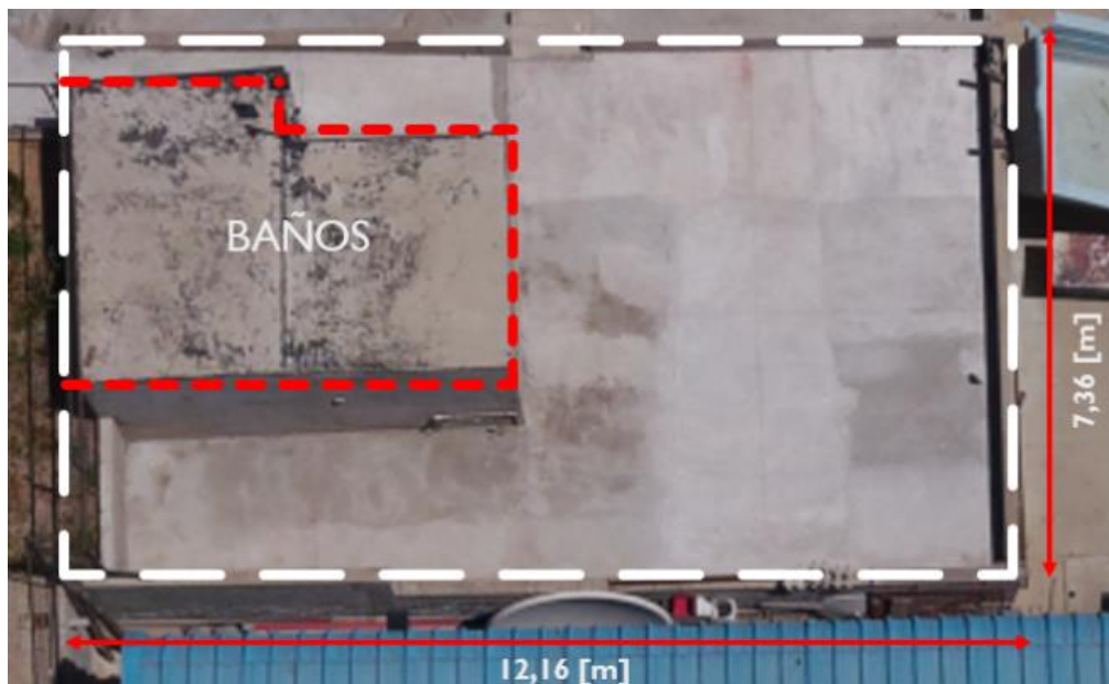
Figura 21: Vista superior área destinada.
