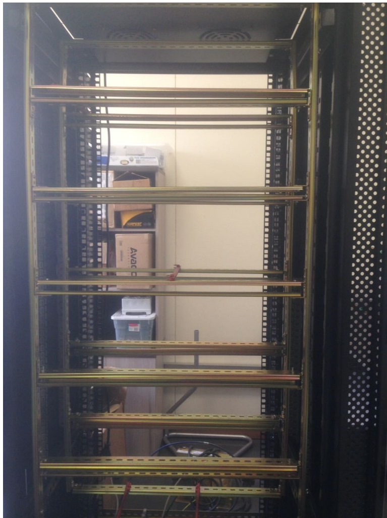
Figura 6.3: Soporte construido para rack
