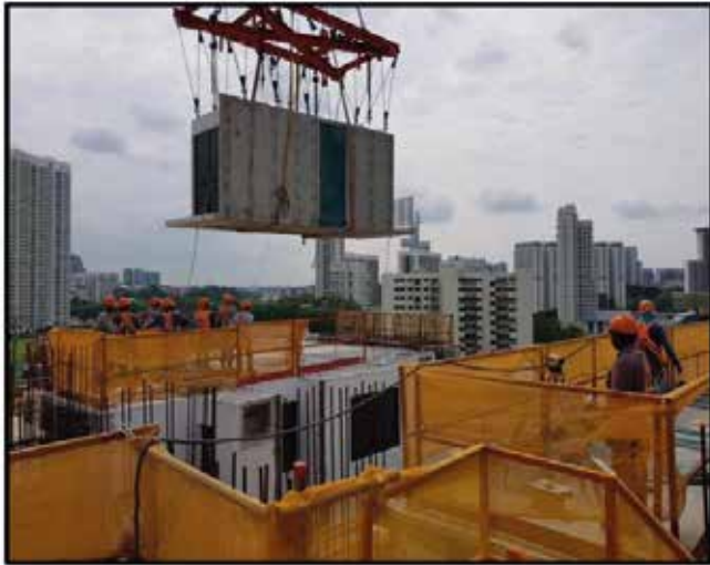
FIGURA 8 | Instalación de módulo PPVC en progreso
