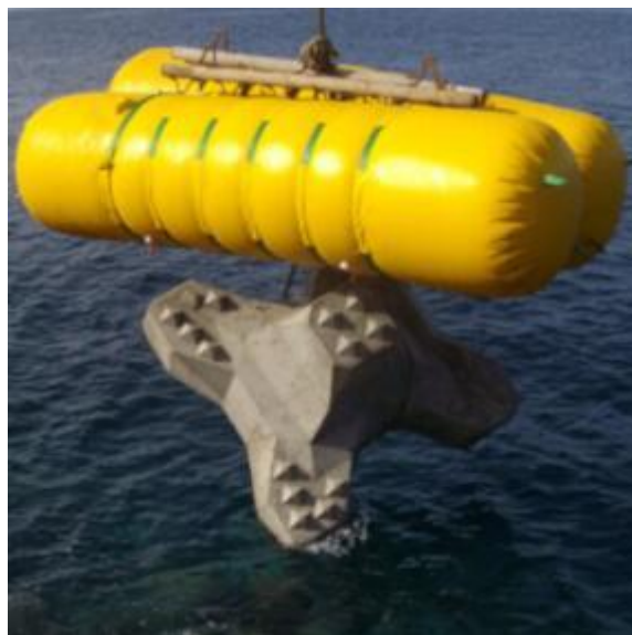
Figura 37. Estructura preparada con sistema de globo de levante para su posterior descenso Fuente. Musthane.com
