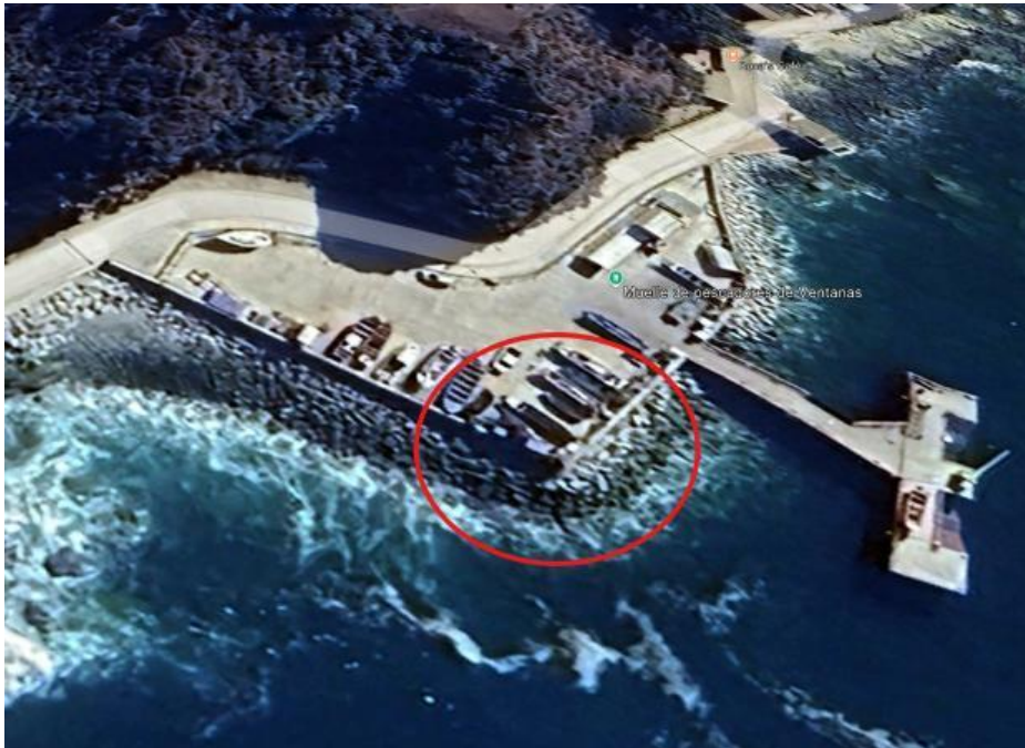
Figura 25. Zona de emplazamiento de la rampa para acceso al medio marítimo Fuente: Google Earth
