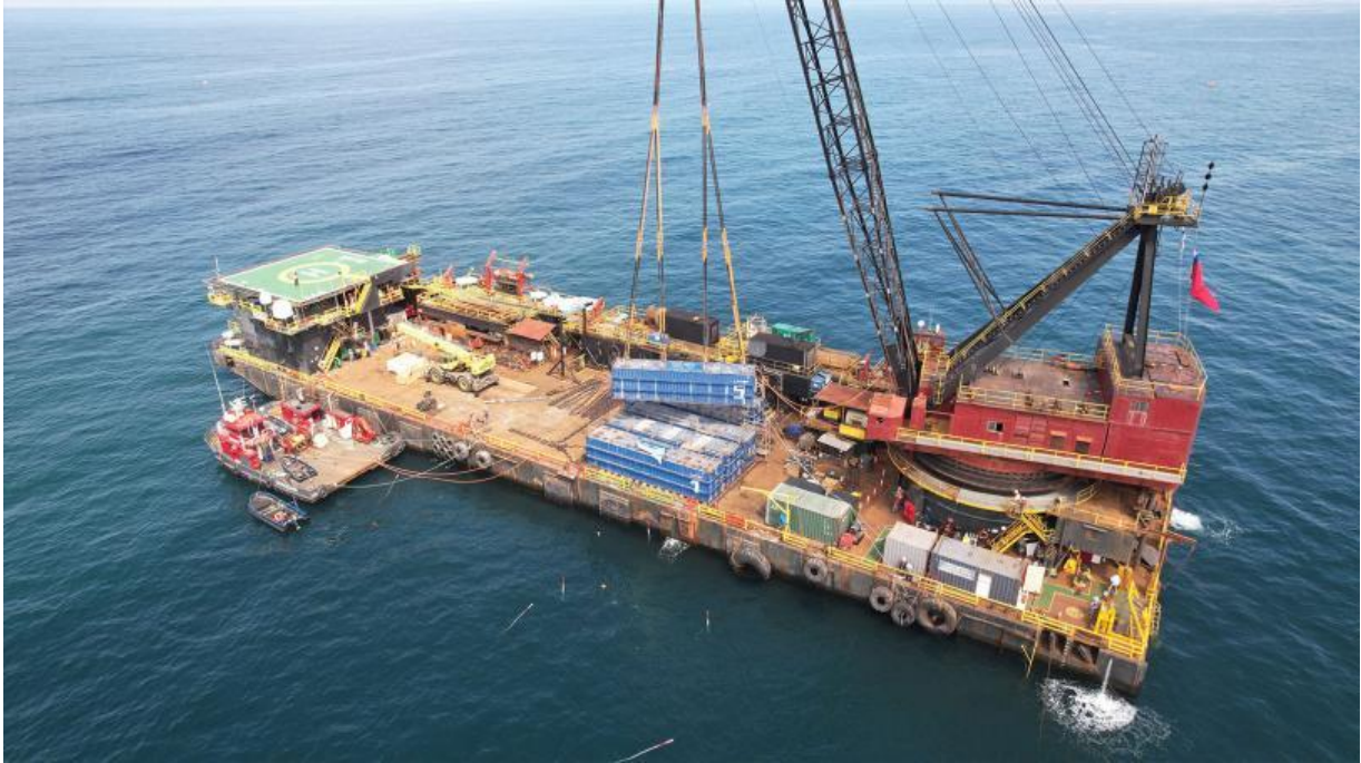
Figura 38. Yagana operando su mecanismo de izaje para proyecto en quebrada blanca Fuente. Compas.marine.cl
