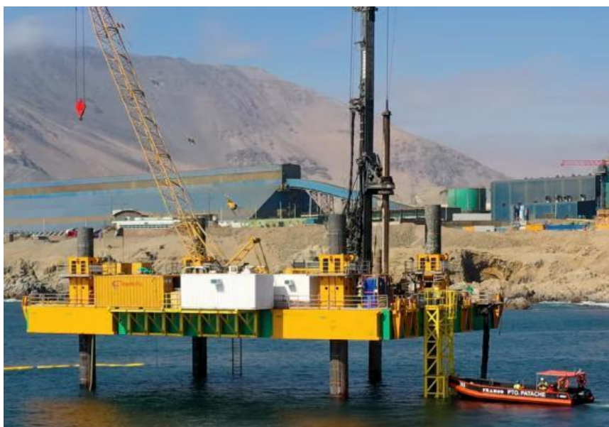
Figura 39. Jack up tipo para realizar las labores de instalación en Bahía de Quinteros Fuente. C20 +, Collahuasi
