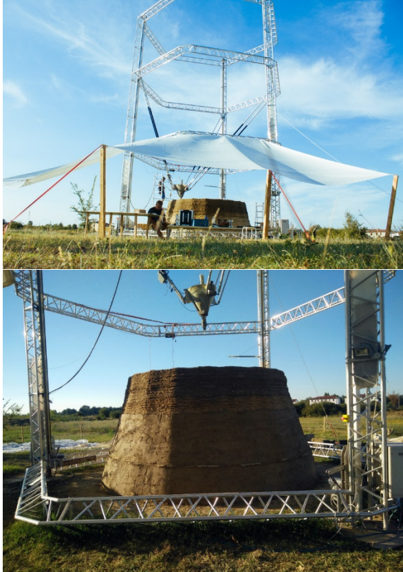
Figura 23: Impresora gigante BigDelta de WASP (Fuente: https://www.3dwasp.com/en/giant-3d-printer-bigdelta-wasp-12m/ ).
