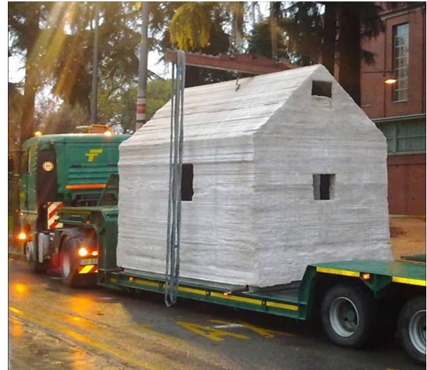
Figura 11: Casa fabricada con el proceso D-Shape (Fuente: https://d-shape.com/what-is-it/the-process/the-concept/ ).
