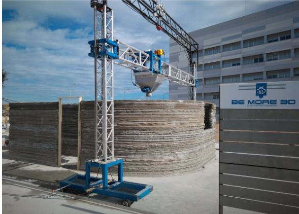
Figura 56: Impresora 3D de hormigón con sistema aporticado móvil (Fuente: https://bemore3d.com/bem-pro2/ ).
