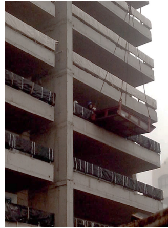
(b) Retiro con cuna - Vista exterior
