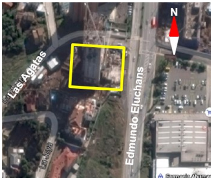
Figura 4.2-1 Foto satelital de la ubicación del edificio Reñacamar
