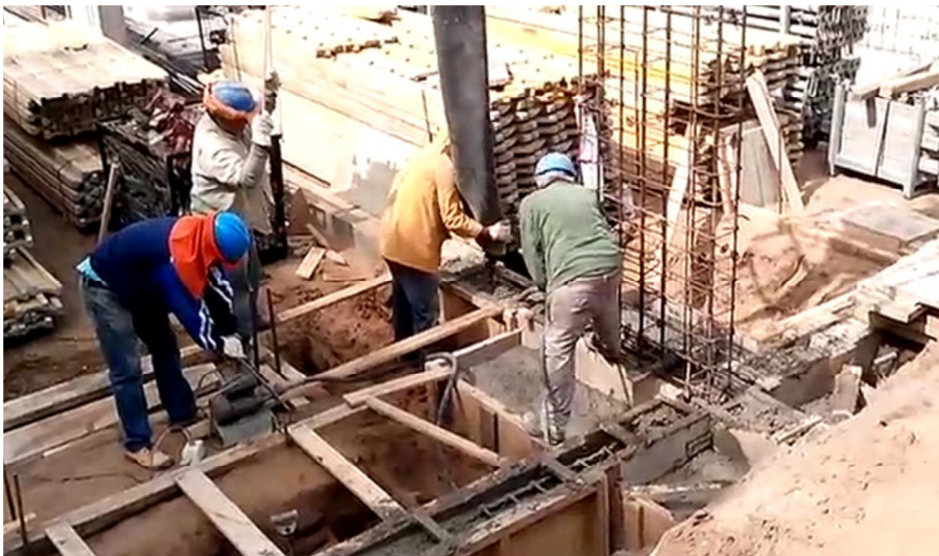
Figura 5.1-3 Utilización de moldaje de madera en hormigonado de zapatas
