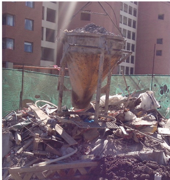
Figura 5.2-8 Residuos listos para ser cargados en el capacho
