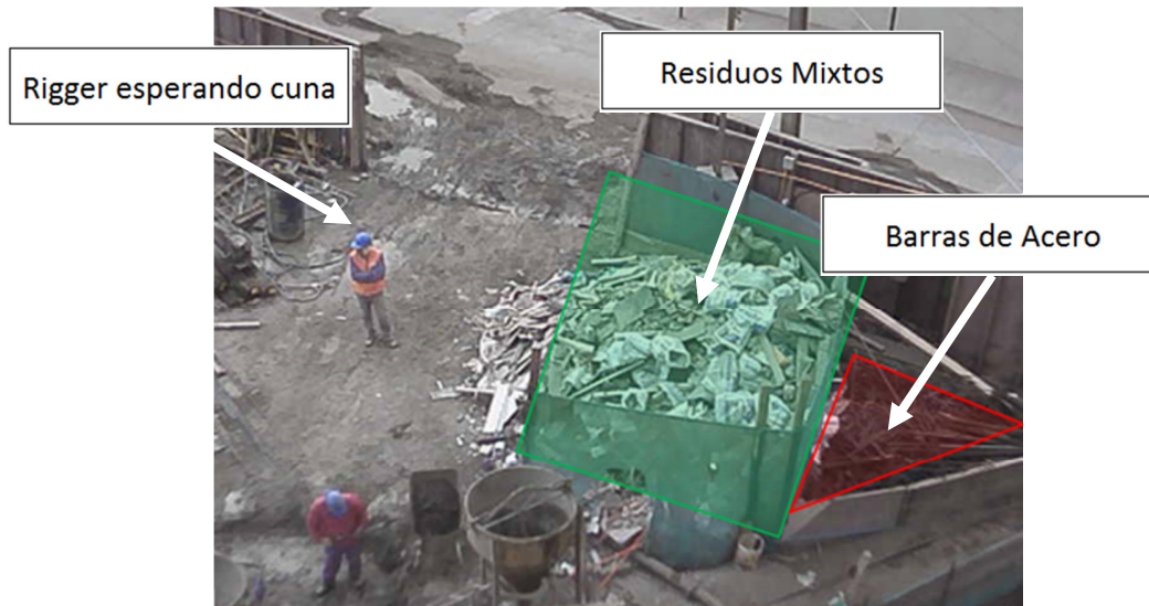
Figura 5.1-1 Zona de Residuos
