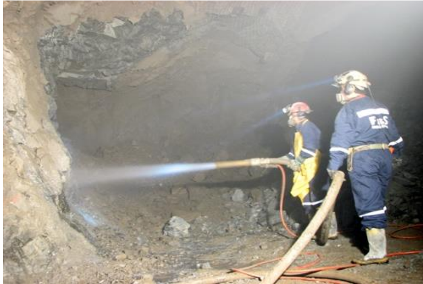
Fig.1-5 Fortificación por shotcrete
