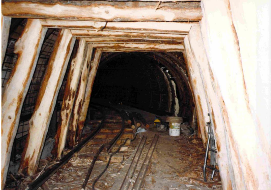
Fig. 1-6 Fortificación con enmaderación
