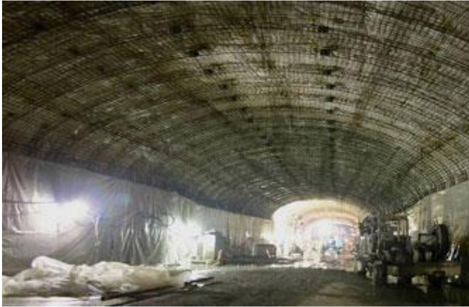
fig. 1-3 fortificación con marcos de acero
