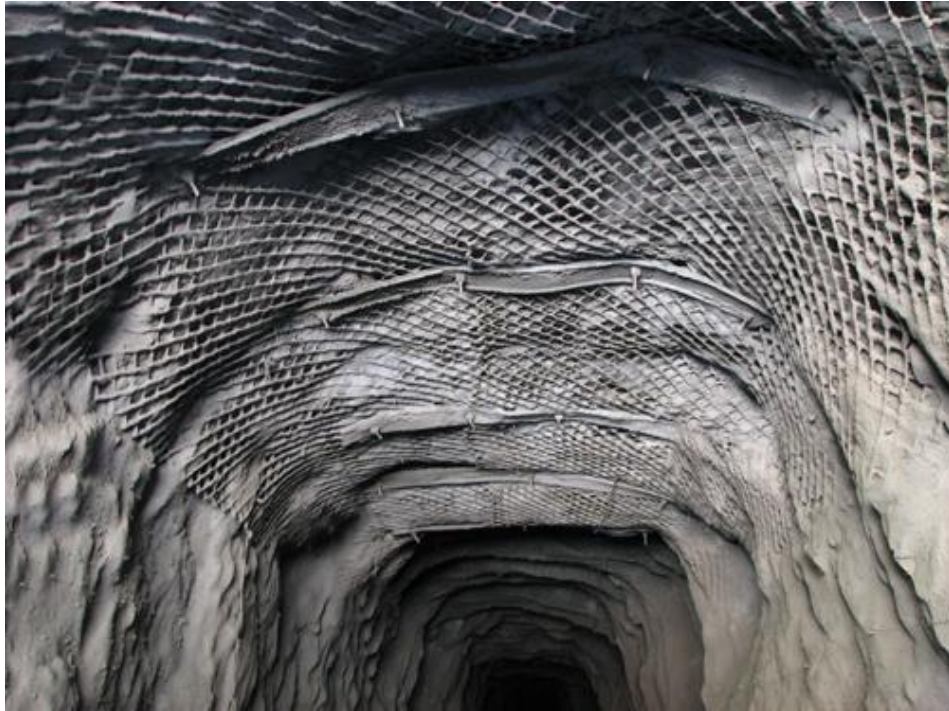
Fig. 1-4 Fortificación con mallas de acero
