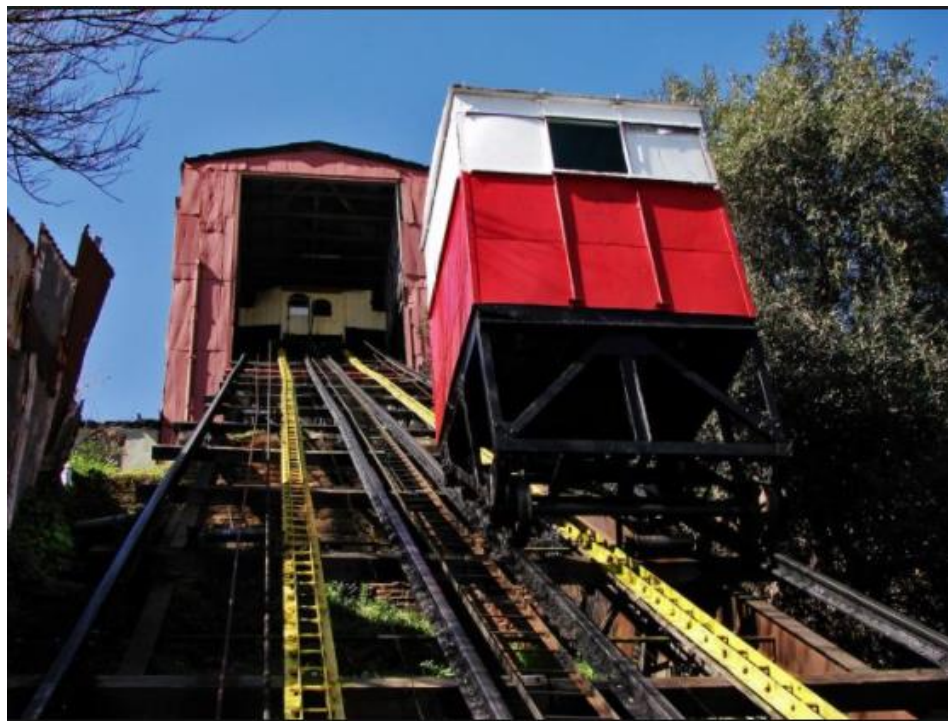
Figura 2.11 Fotografía carro del ascensor Larraín (8)
