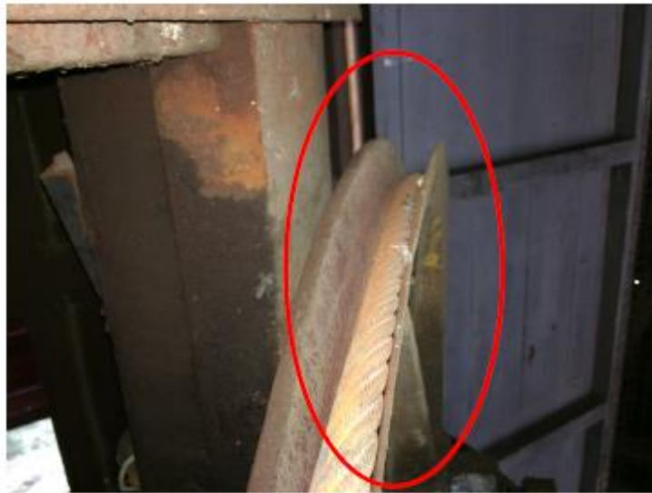
Figura 3.2 Desgaste en poleas de compensación (14)
