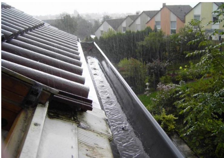
Figura 2-6 canales de conducción fuente “ www.Google.cl ”
