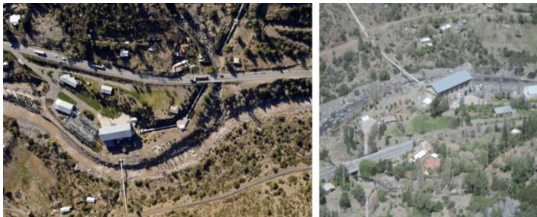
Figura 31. Vistas aéreas de la central Aconcagua.
