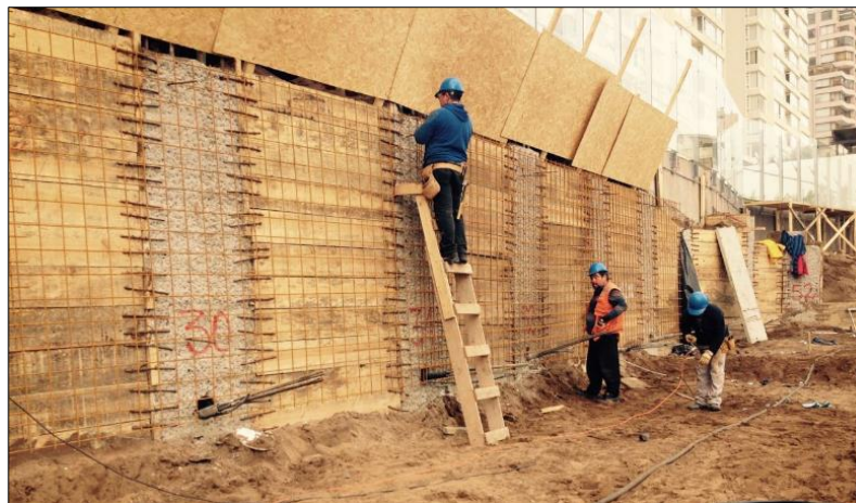
Figura 4-11: Primera línea de anclajes.
