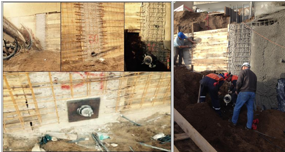
Figura 4-12: Tensado de anclajes.
