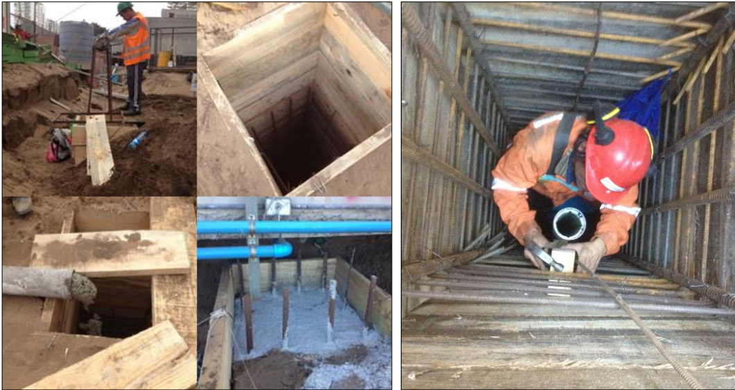
Figura 4-9: Ejecución pilas.
