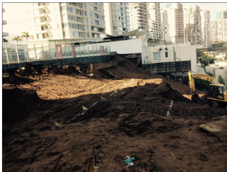
Figura 4-10: Excavación con taludes.
