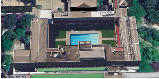
(a) Vista aérea del edificio B, para donde se planifica la implementación.
