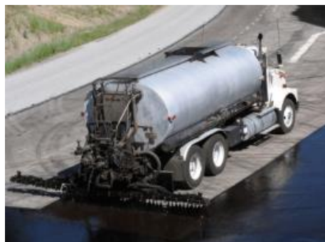
Ilustración 10: Aplicación de riego de liga con camión imprimante.
