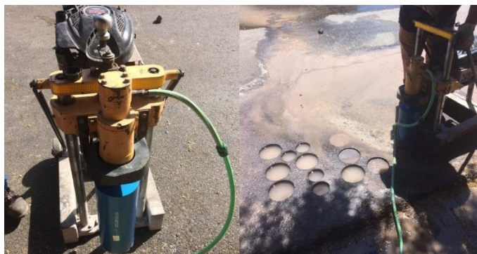
Ilustración 31: Extracción de testigos del tramo de pruebas.
