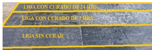
Ilustración 15: Diferenciación entre tiempos de curado de 24 h., 2h. y sin curar en tramo de pruebas.
