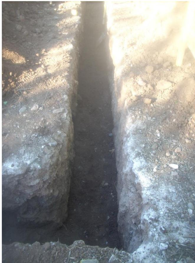
Figura 2.3. Excavaciones para fundaciones.
