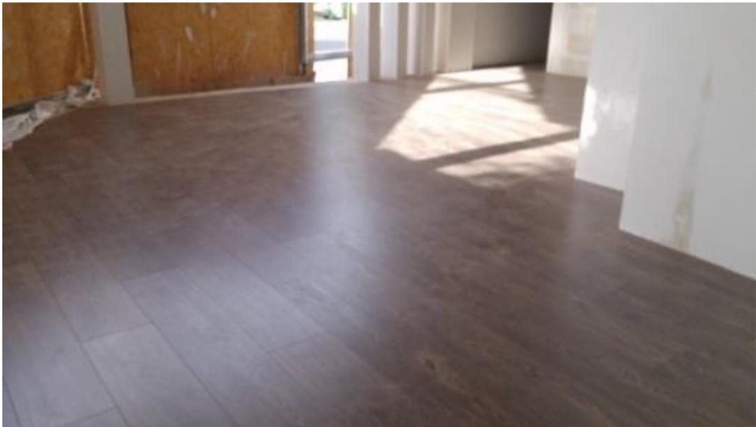
Figura 2.3.6. Instalación de Piso Flotante Proximo a ser Terminado.
