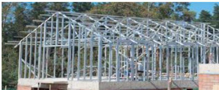
Figura 2.3.3. Estructura Segundo Piso Metalcon.
