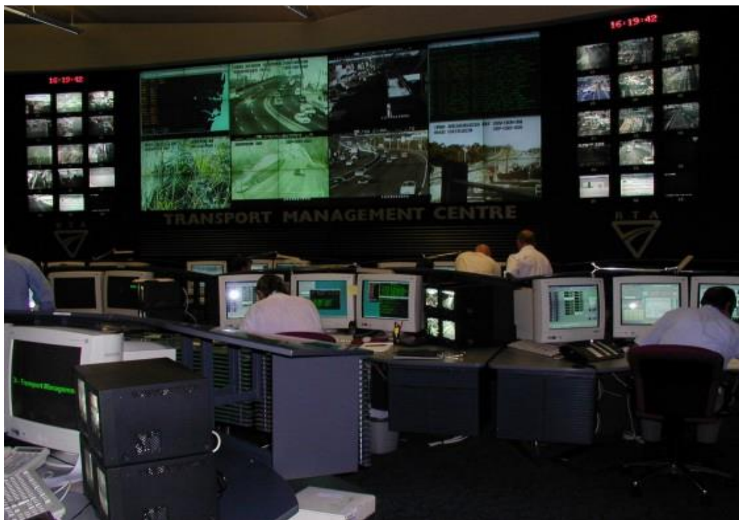
Figura N° 17 Sala de Control Tipo
